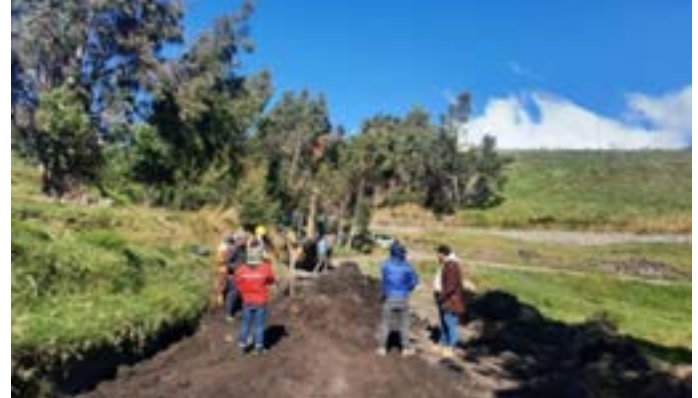
Trabajos de excavación
