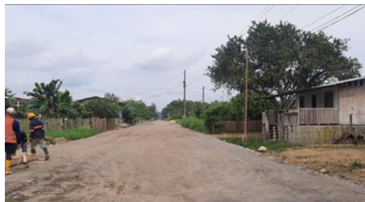
Mejoramiento de suelo para el asfaltado de la vía Las Maravillas – Agrupación Los Ríos, en Puerto Quito
