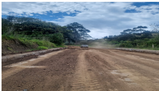
Adoquinado y cunetas de la calle Carlota Díaz del centro poblado, parroquia Santa Rosa de Cuzubamba, cantón Cayambe - Antes
