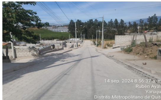
Adoquinado de varias calles De Los Molinos, barrio La Victoria, parroquia Yaruquí, cantón Quito - En ejecución
