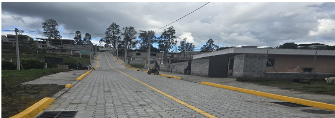
Adoquinado de varias calles De Los Molinos, barrio La Victoria, parroquia Yaruquí, cantón Quito - Terminada
