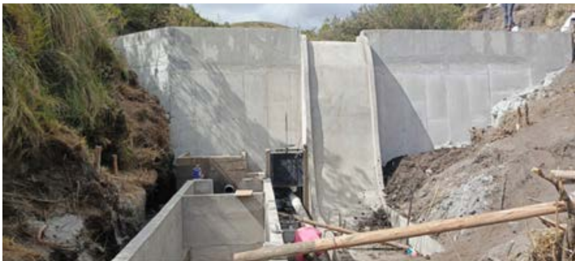
Construcción del sistema de riego Pucará sector El Bajío, parroquia El Chaupi, cantón Mejía
