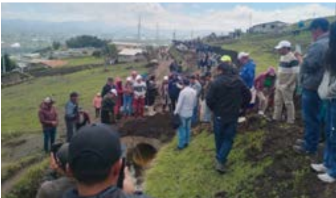
Participación de los beneficiarios durante trabajos comunitarios (mingas) para la instalación de tubería de la conducción del sistema de riego
