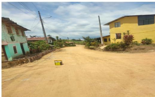
Adoquinado y bordillos, calles internas de la comunidad Santa Teresita, parroquia Pacto, cantón Quito - Antes
