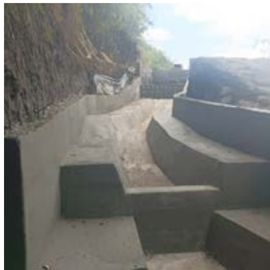
Construcción de desarenador y obras complementarias en el ramal 45c
