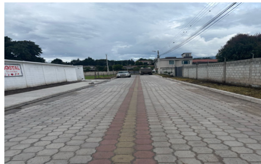
Adoquinado y bordillos de la calle Segundo Amaguaña, comuna Chiche Anejo, parroquia Puembo, cantón Quito
