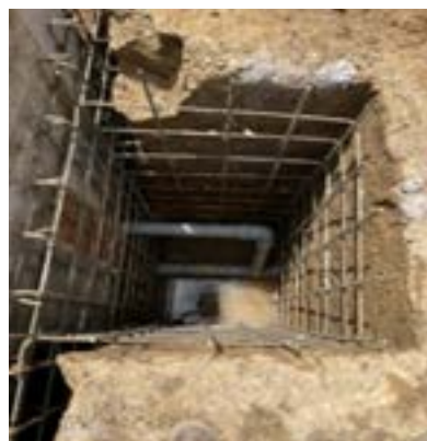
Caja de válvulas del sistema de riego
