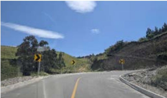
Vía La Bola-Larcachaca
