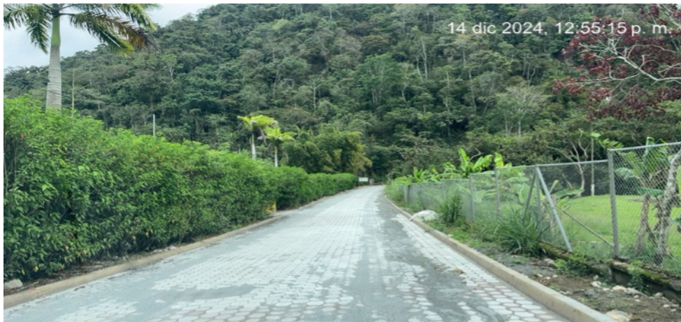
Adoquinado, cunetas y bermas en el tramo río Alambí – San Pedro, tramo Palmitopamba, Alambí del barrio San Pedro y Palmitopamba, parroquia Nanegal, cantón Quito – Terminada
