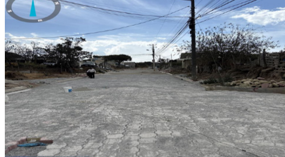
Adoquinado, bermas, bordillos y rejillas para sumideros en la calle Los Nogales, parroquia Llano Chico, cantón Quito - En ejecución
