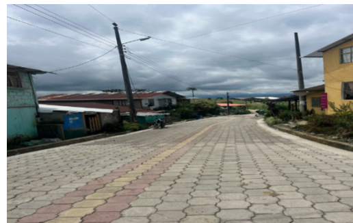
Adoquinado y bordillos, calles internas de la comunidad Santa Teresita, parroquia Pacto, cantón Quito - Terminada
