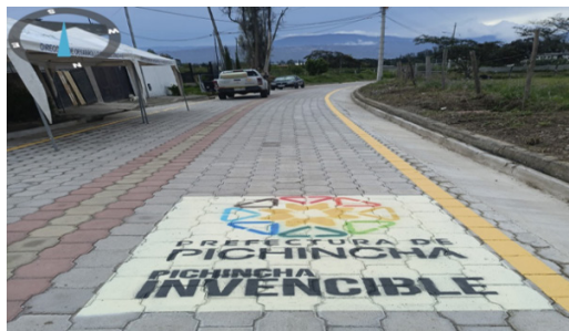
Adoquinado y cunetas de la calle Los Sauces, barrio San Pedro, parroquia Ascazubi, cantón Cayambe - Terminada
