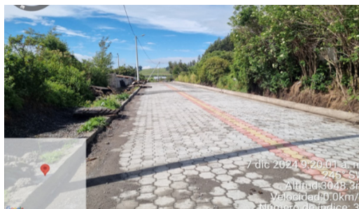
Bordillo, bordillo-cuneta y adoquinado de la vía principal, comunidad Moyurko, parroquia Olmedo, cantón Cayambe - Terminada
