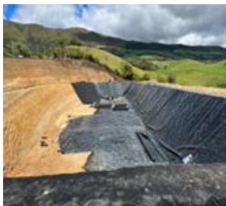
Impermeabilización de reservorio
