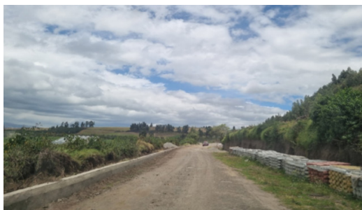
Bordillo, bordillo-cuneta y adoquinado de la vía principal, comunidad Moyurko, parroquia Olmedo, cantón Cayambe - En ejecución
