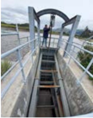
Actividades de mantenimiento y operación de la zona media
