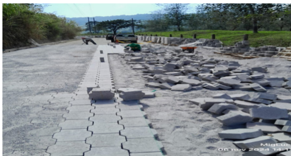
Adoquinado, cunetas y bermas en el tramo río Alambí - San Pedro, tramo Palmitopamba, Alambí del barrio San Pedro y Palmitopamba, parroquia Nanegal, cantón Quito - Antes
