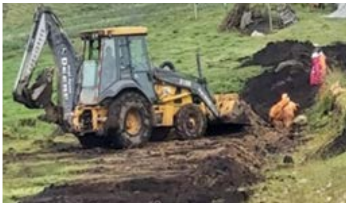
Excavación de tubería de las redes terciarias
