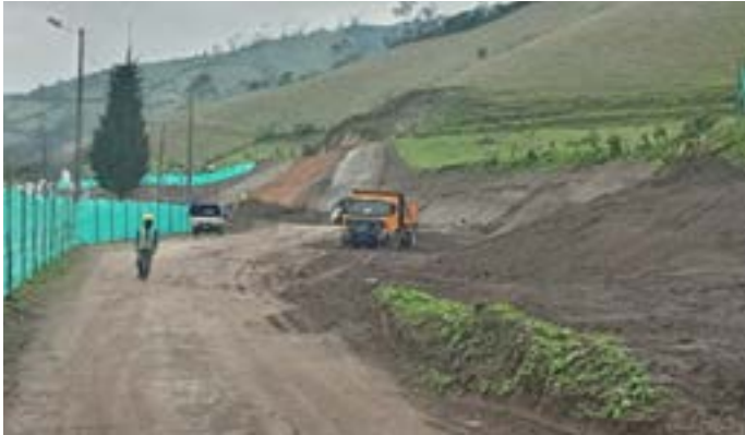
Construcción Peaje Calacalí
