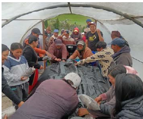
Instalación de biodigestor en la comuna Turucucho (Olmedo) como parte del ACUS Bosque Alto Andino.
