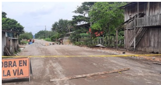
Mejoramiento de suelo para el asfaltado de la vía Las Maravillas – Agrupación Los Ríos, en Puerto Quito
