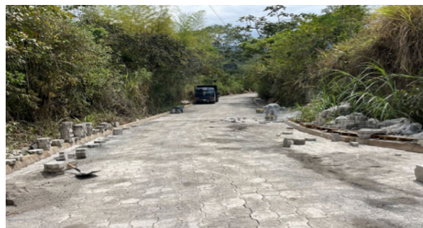
Adoquinado, cunetas y bermas en el tramo río Alambí - san pedro, tramo Palmitopamba, Alambí del barrio san pedro y Palmitopamba, parroquia Nanegal, cantón Quito - En ejecución
