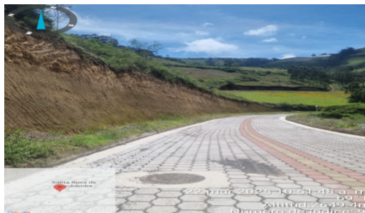
Adoquinado y cunetas de la calle Carlota Díaz del centro poblado, parroquia Santa Rosa de Cuzubamba, cantón Cayambe - Terminada
