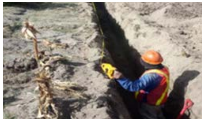
Excavación de tubería de las redes terciarias
