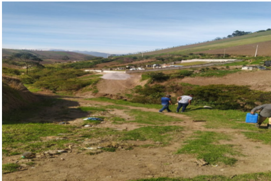
Adoquinado y bordillos, muro de alas y alcantarilla para la vía 4 esquinas - cementerio, comuna Coyagal, parroquia Puéllaro, cantón Quito - Antes
