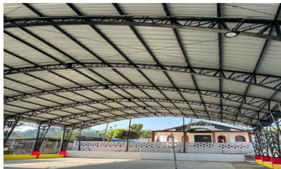
Base de hormigón, estructura metálica, iluminación y drenaje en la cancha de uso múltiple del barrio El Porvenir, parroquia Gualea, cantón Quito - Terminado
