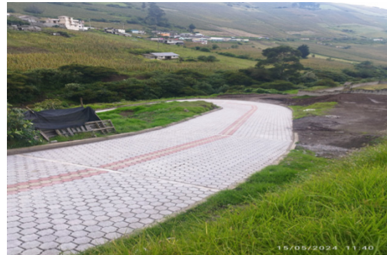
Adoquinado y bordillos, muro de alas y alcantarilla para la vía 4 esquinas - cementerio, comuna Coyagal, parroquia Puéllaro, cantón Quito - Terminado
