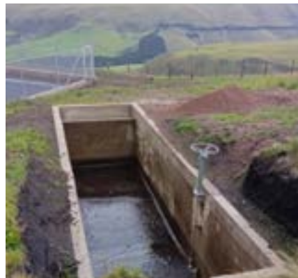
Desarenador y reservorio al fondo
