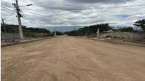
Adoquinado, bermas, bordillos y rejillas para sumideros en la calle Los Nogales, parroquia Llano Chico, cantón Quito - Antes
