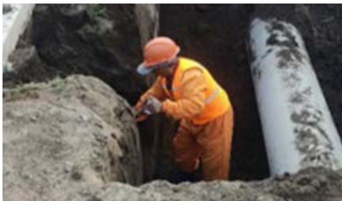
Colocación de la tubería de las redes terciarias
