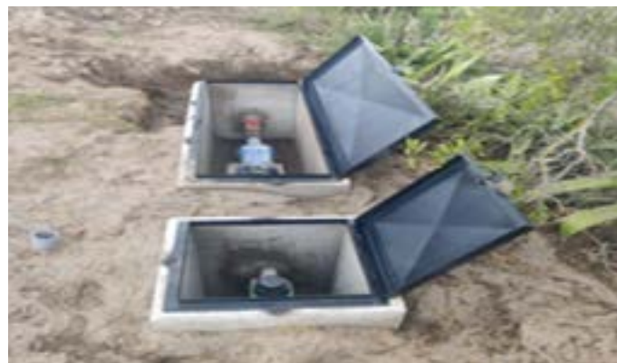
Instalación de accesorios de las redes terciarias
