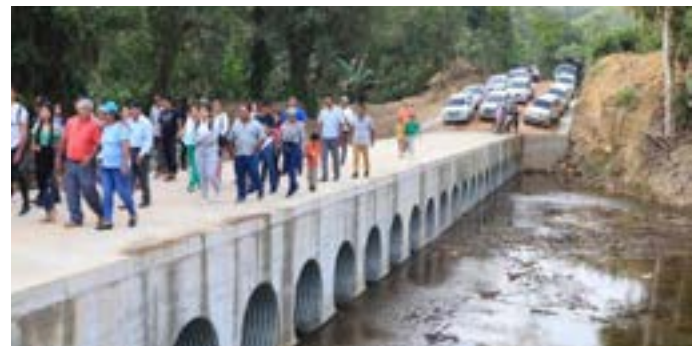
Alcantarilla en batería sobre el río Cubera en el km 6 de la vía Limón -Santa Fe del cantón Puerto Quito
