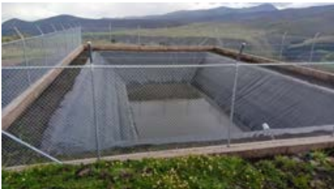
Vista general de reservorio
