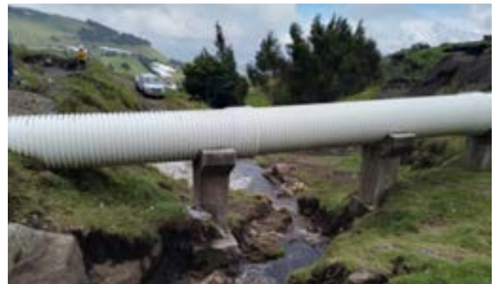
Instalación de tubería de 1000 mm de diámetro en la conducción del sistema de riego
