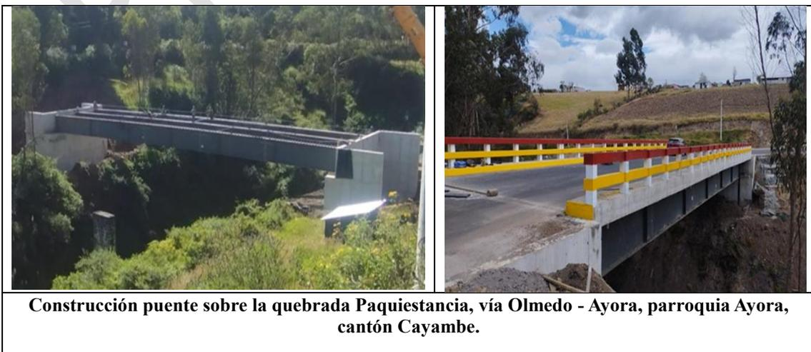
La Construcción del Puente sobre la Quebrada PAQUIESTANCIA en la vía Olmedo - Ayora, parroquia Ayora, cantón Cayambe, tiene una Longitud de 40 metros y tramos de aproximación totales de 300 m, con una Inversión de aproximadamente 613 mil dólares, las actividades realizadas fueron: construcción de la infraestructura y superestructura del puente, tramos de acceso y señalización, se encuentra finalizada y en servicio de la comunidad.
