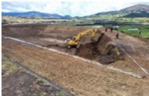
Construcción reservorio sector Cascajo, parroquia Olmedo
