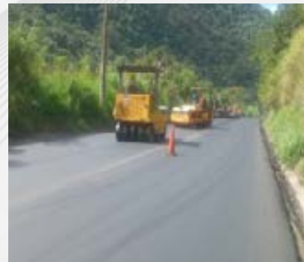
Compactación de capa de rodadura
