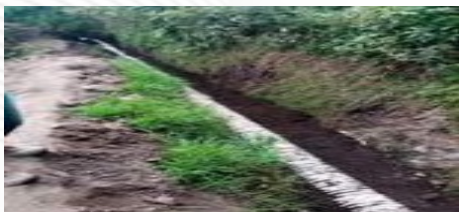
Instalación de tubería en la red de conducción del sistema de riego La Pirca
