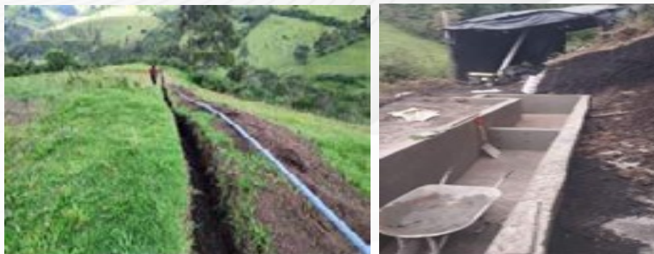
Mejoramiento del sistema de riego El Carmen, parroquia Checa, cantón Quito
