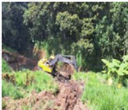
Limpieza de alcantarillas
