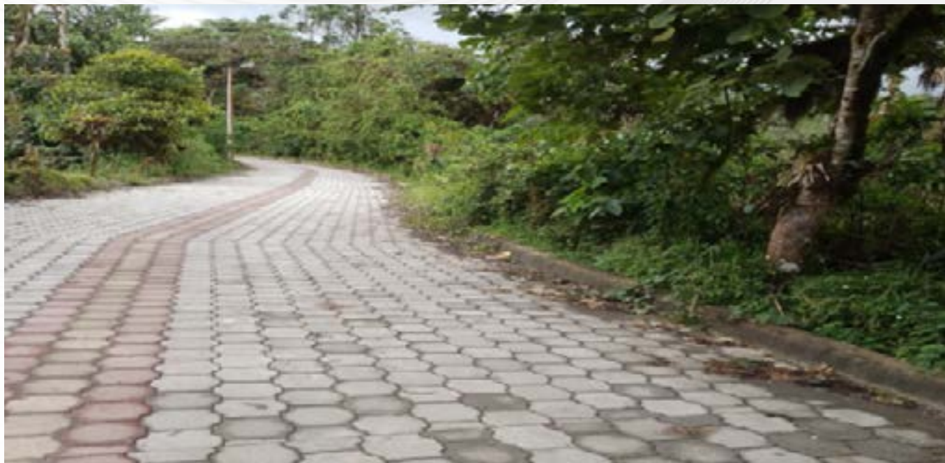
Adoquinado y bordillos calle ingreso al barrio Miraflores, parroquia Nanegalito
