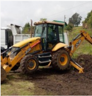
Trabajos con maquinaria
