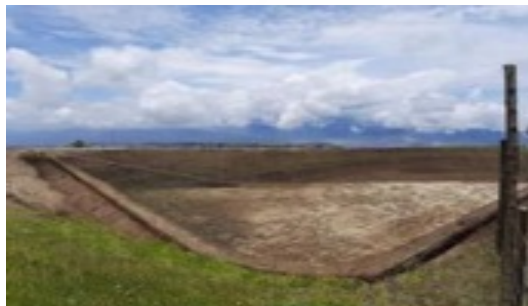
Proceso constructivo del reservorio, sector Yanatola
