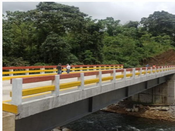
Construcción del puente sobre el río Espejo, ubicado en el recinto Bernardo Valdivieso, cantón San Miguel de Los Bancos.
