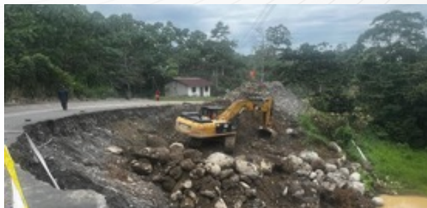
Sector Piedra de Vapor - cantón Puerto Quito, recuperación de la mesa de la vía.
