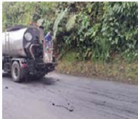
Riego de emulsión
