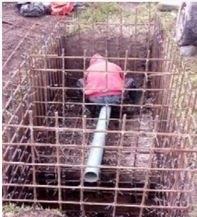
Construcción de un tanque rompe presión en Olmedo del sistema de riego Pesillo COINOA.
