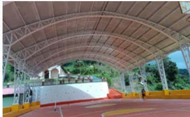
Estructura metálica, colocación de cubiertas, pintura, iluminación y drenaje para la cancha de uso múltiple, barrio San Carlos, parroquia San José de Minas.
