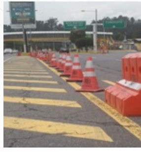
Señalización (conos y jersey)
