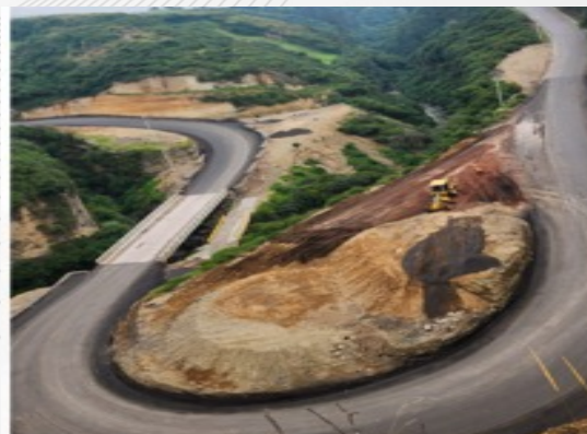
Construcción de los accesos al puente sobre la quebrada Rumihuico
