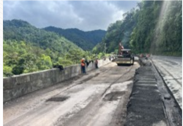
Toma densidades mejoramiento tras muro Km. 70+980 Trabajos de ampliación
