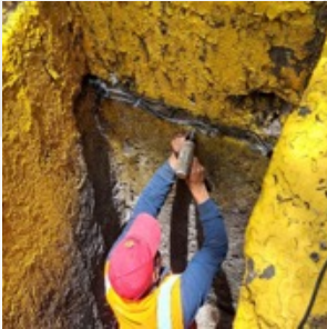
Trabajos de obra civil
