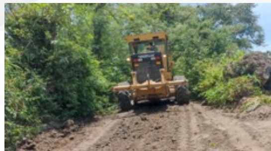
Sector San José de Minas, rasanteo y mantenimiento vial.
