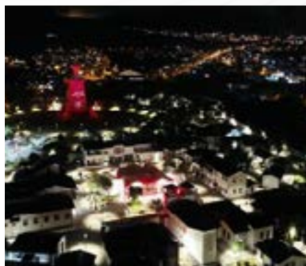
Reemplazo e implementación de tecnología de alumbrado público ornamental.
