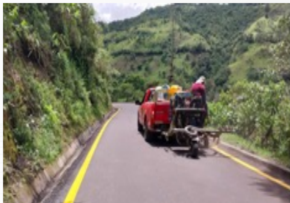
Mejoramiento de la vía de acceso a Yunguilla
