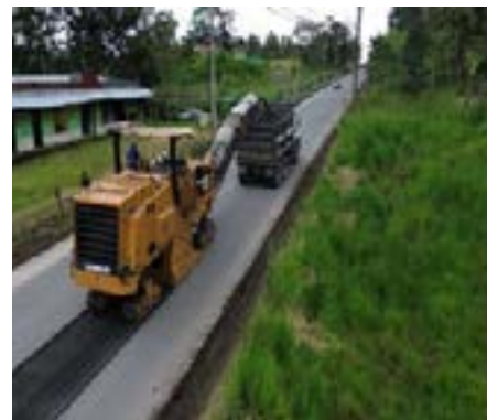
Fresado de pavimento asfáltico
