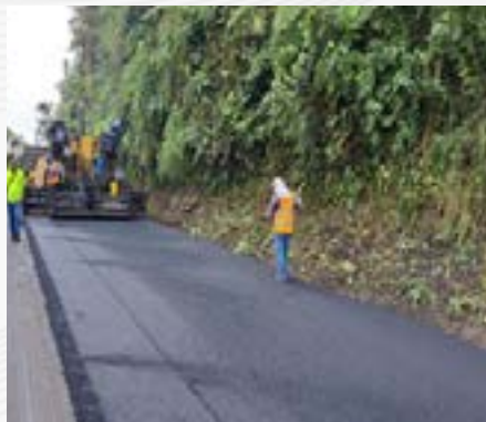
Tendido de asfalto
