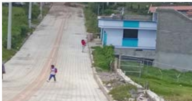
Adoquinado calle F, barrio El Capulí, parroquia Tambillo.
