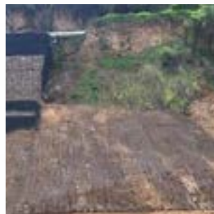
Obra de protección La Remonta, parroquia Ayora
