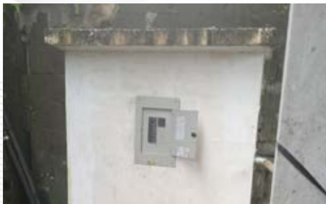
Cambio de tablero de distribución principal y alimentadores de subtableros en el campamento zona 4 Los Bancos.
