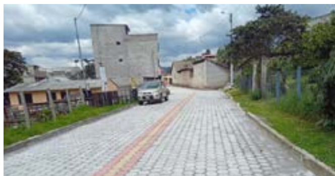
Adoquinado y bordillo bajo calles S/N y calle 15, barrio La Libertad, parroquia Cotogchoa (240 mts de bordillo)
