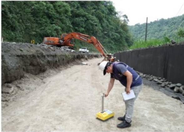
Toma densidades mejoramiento tras muro Km. 70+980
