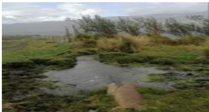
Tramos vulnerables del canal de riego Yeguapamba, parroquia Pintag
