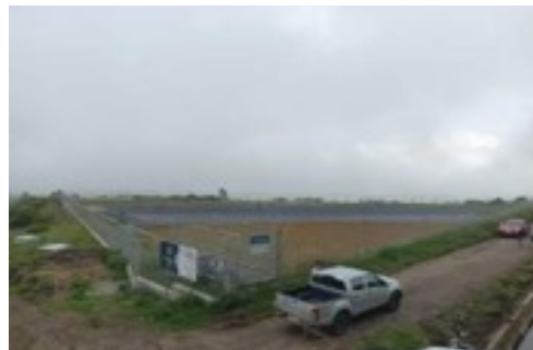
Cerramiento del reservorio del ramal 45C, parroquia Malchinguí
