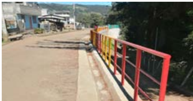
Muro de gaviones ingreso a la comunidad, barrio La Vaquería, parroquia Amaguaña.
