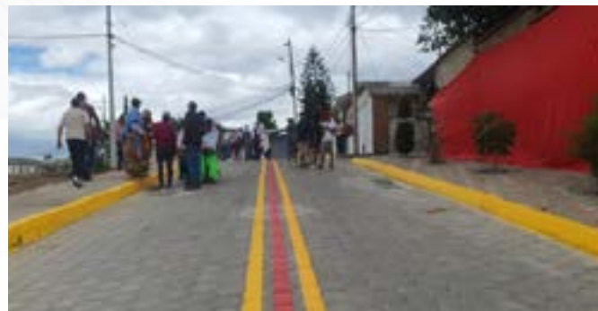
Varias calles sector Bellavista barrio Chaupimolino, parroquia de Pífo.
