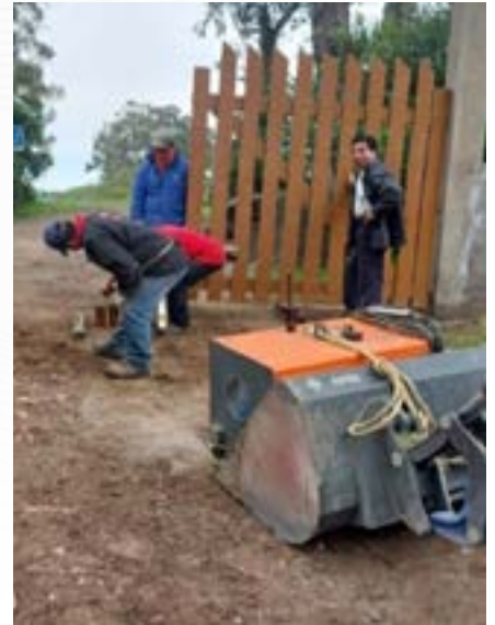
Portón del área de camping
