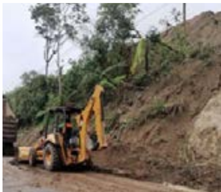
Limpieza de derrumbes
