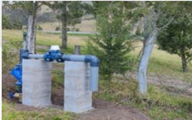
Cabezal de riego instalado en el ramal 44C en Malchingui.
