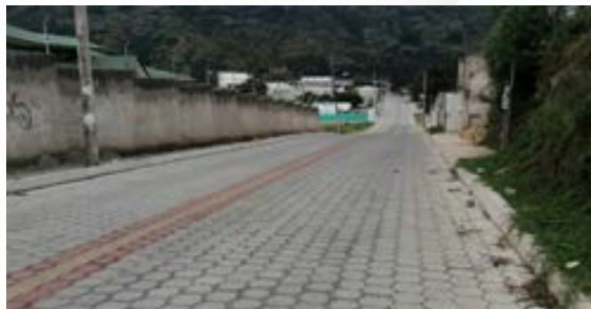
Adoquinado y bordillos calle Los Nísperos, comunidad Angamarca, parroquia Alangasí.
